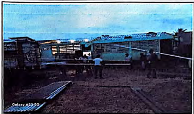
Foto 2. Sustitución cubiertas de láminas
