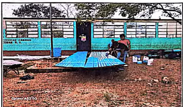
foto 4. mantenimiento de estructura metalica.
