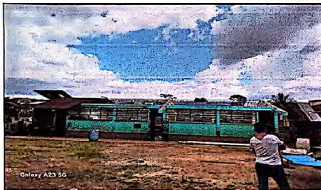
foto 3. desinstalacion de láminas.
